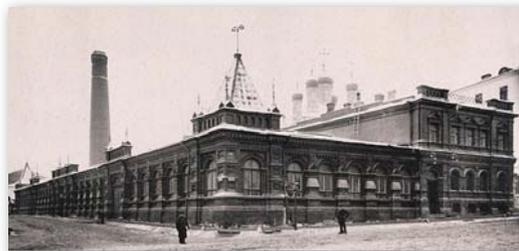
В 1888 г. «Общество электрического освещения 1886 года» построило на углу Большой Дмитровки и Георгиевского переулка в Москве первую относительно мощную электростанцию, способную снабжать электроэнергией частных потребителей. На станции вырабатывался постоянный ток напряжением 120 В, который поступал к абонентам по подземным кабелям
